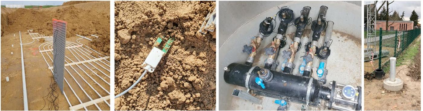
Abbildung 2: Einbau diverser Messtechnik im Rahmen von KNW-Opt am Erdwärmekollektorsystem. Von links nach rechts: Temperaturfühler zwischen den Kollektorebenen, Feuchtefühler innerhalb des Kollektors, Wärmemengenzähler und Temperaturfühler an den Verteilerschächten, Grundwassermessstellen.
