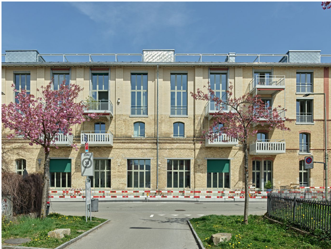
Lokstadt, Stadthäuser 1. Etappe: Wandelbarkeit der Industriearchitektur am Beispiel der überformten Portalfassade des ehemals abgeschlossenen Areals. ARGE KilgaPopp Architekten / Baumberger&Stegmeier Architekten 2016 – 2023
