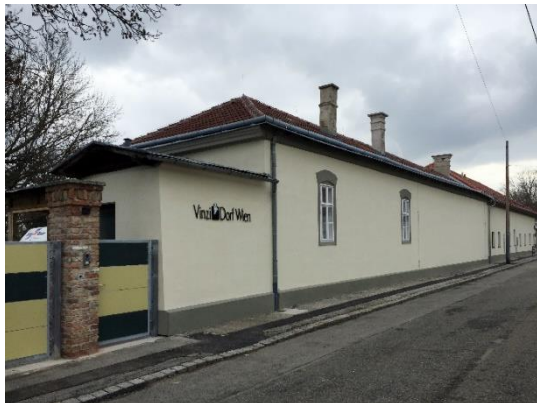
Abbildung 1: Das renovierte Bestandsgebäude und der Eingang zum VinziDorf Wien in der Boergasse (© gaupenraub+/-)
