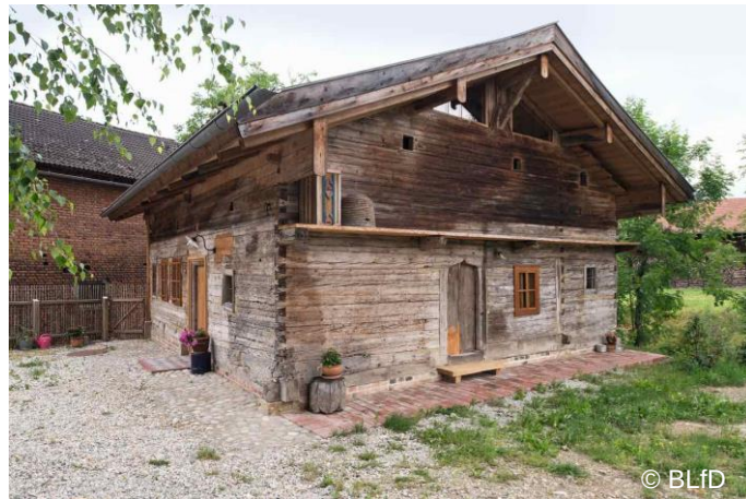
Abbildung 1: Substanzschonend und behutsam instandgesetztes Bauernhaus
