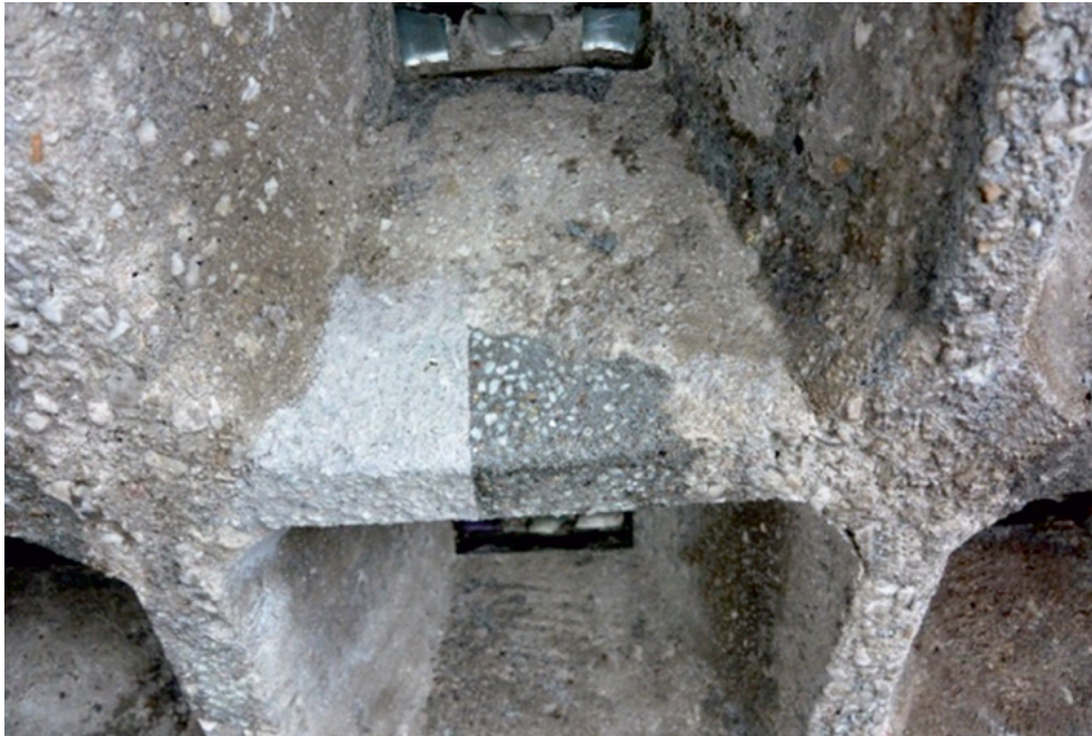
Abbildung 1 Ausschnitt aus Schadenskartierung Betonwaben Kapelle Kaiser-Wilhelm Gedächtniskirche (Ewerien 2014)
